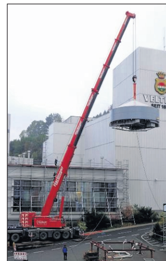
Der erste Läuterbottich mit einem Durchmesser von 8,5 Metern schwebte millimetergenau in das bestehende Sudhaus ein. Im Frühjahr und Herbst 2015 folgen die zwei weiteren Läuterbottiche im Austausch.
